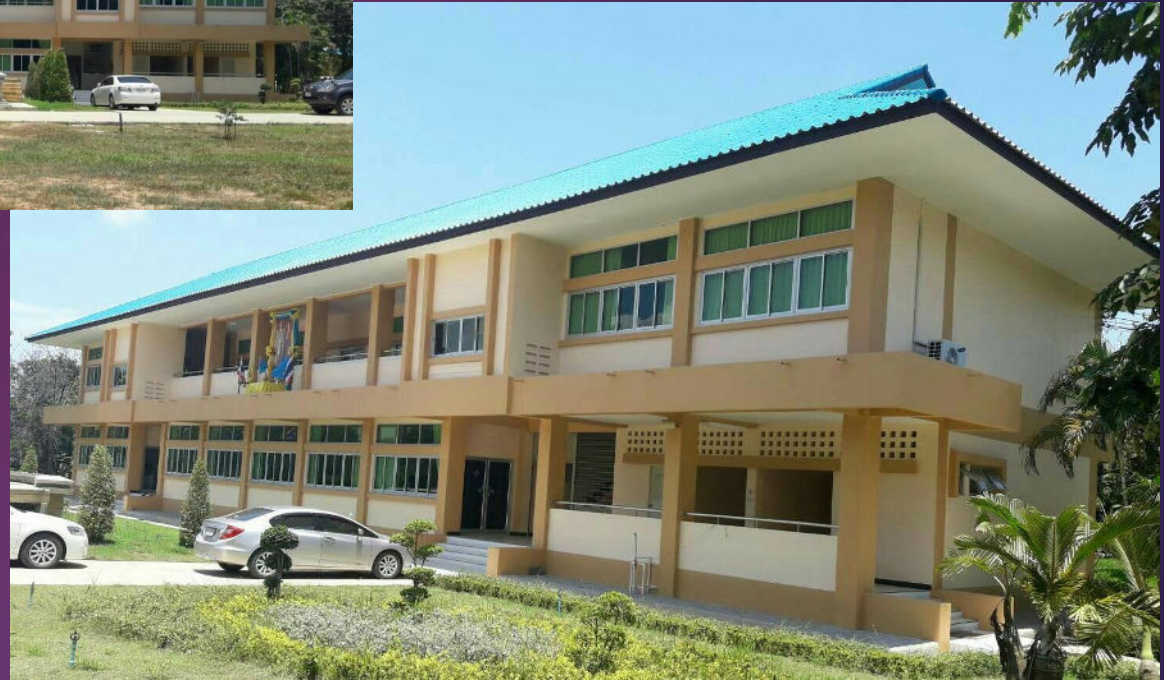
อาคารสำนักงานเขตพื้นที่การศึกษา แบบที่ 4 กรอบอาคาร 14.90 x 48.40 เมตร สูง 8.05 เมตร
