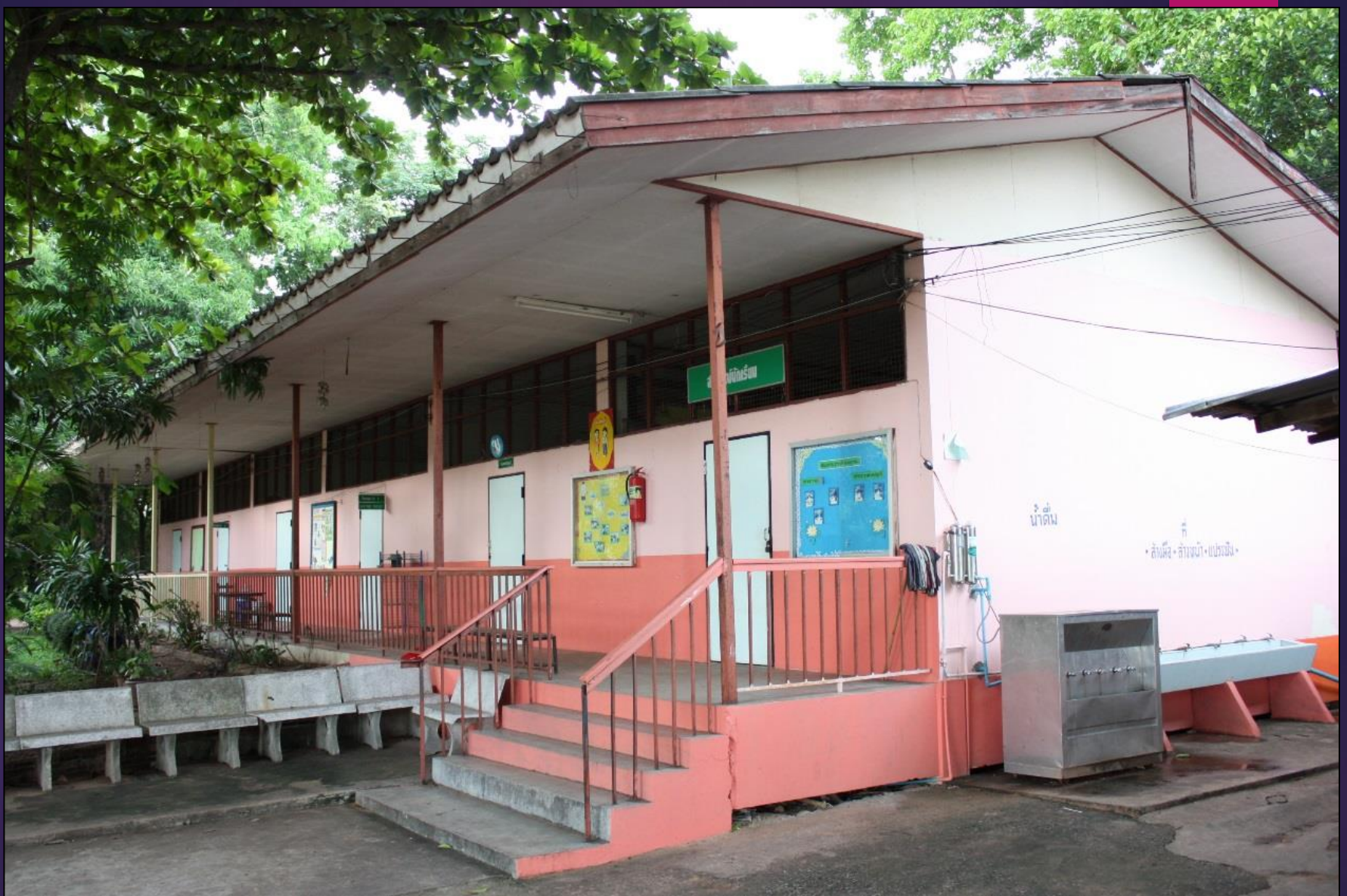
สปช. 103/26 อาคารเรียนชั้นเดียว 3 ห้องเรียน (พื้นที่สูง) กรอบอาคาร 11.70 x 29.00 เมตร สูง 4.40 เมตร
